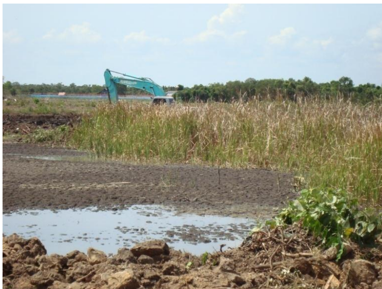
ภาพผนวกที่ 5 ขุดคูขกร่องเพื่อปลูกปาล์มน้ำมันพื้นที่พรุ
